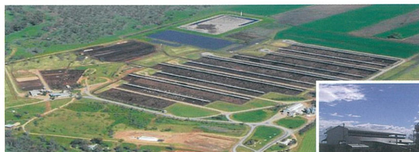
フィードロット外観全景 (上)
